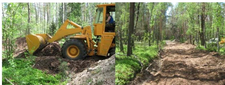
Рисунок 5 – Работа погрузчика при разравнивании отходов по дорожному полотну
