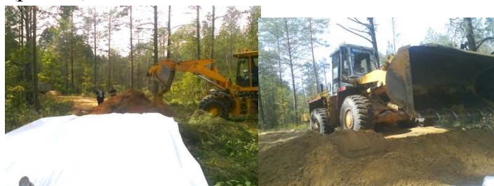
Рисунок 6 – Укладка геосинтетической прослойки и отсыпка грунта по его поверхности
