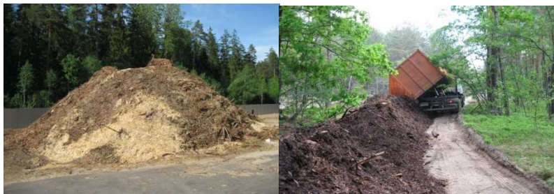
Рисунок 4 – Процесс отсыпки отходов
