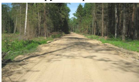
Рисунок 7 – Общий вид устроенного опытного участка
