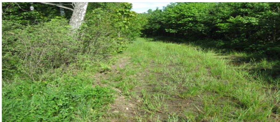
Рисунок 2 – Общий вид подъездного пути до строительства
